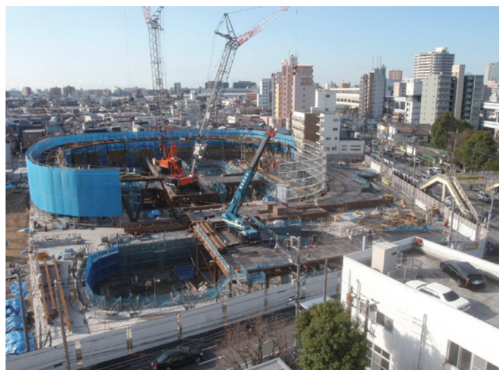
〈工事の状況(2011年3月)〉
